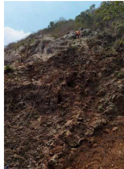
Dok. Mawapala Aplikasi Pemanjatan Artificial Climbing di jalur Genset
